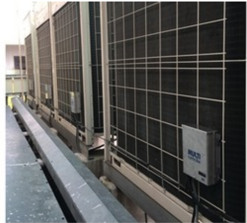
サンアップ・コーポレーション（タイランド）が提供するエアコンの省エネ事業で使うコンプレッサーを自動制御するためのマルチコントローラー（同社提供）
